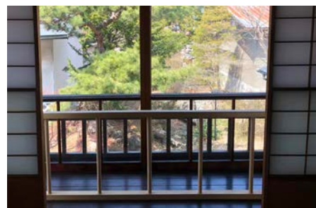
写真 26. 2階に増設された手すり部分
